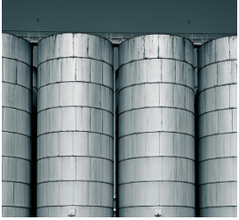
TANK İÇ KAPLAMALARI
